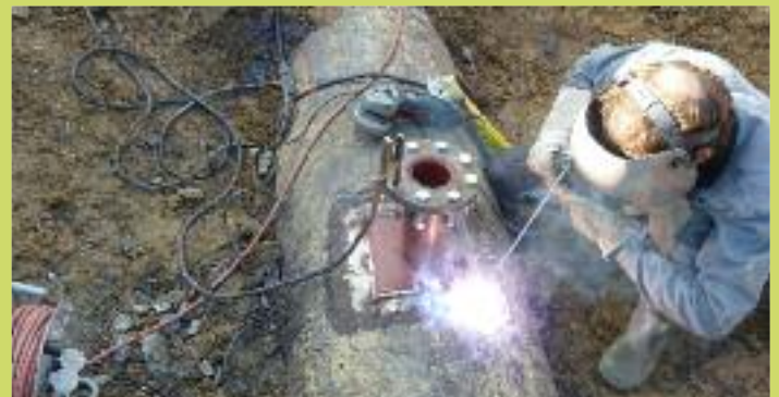
Remplacement du piquage de la ventouse de Bordeneuve.
