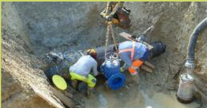
Remplacement de la vidange de l'Engranot (Saint-Félix-Lauragais).
