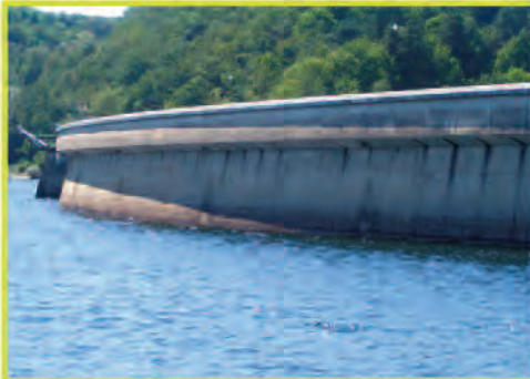
Le parement amont
