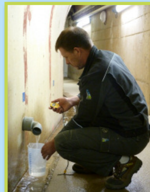
Mesure de débit des drains dans la galerie du barrage de la Galaube
