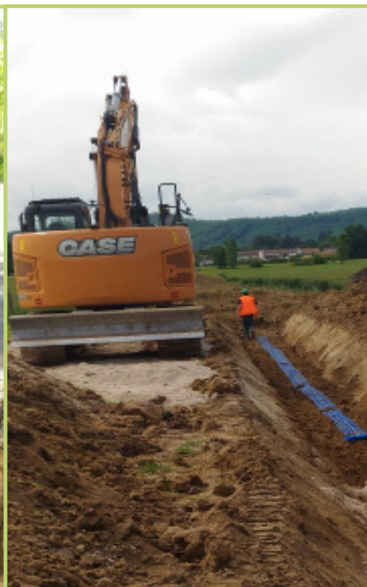
Remblais et pose du grillage avertisseur par SOGEA à Guitalens-l'Albarède.
