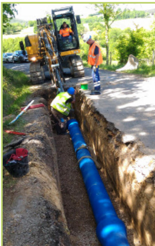
Pose d'un tuyau en Ø 250 mm par l'entreprise SADE à Moulayries.
