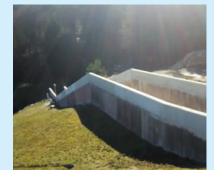
Bajoyers de l'évacuateur de crue réhaussés.
