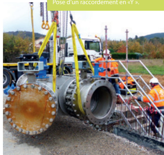
Pose d'un raccordement en «Y».
