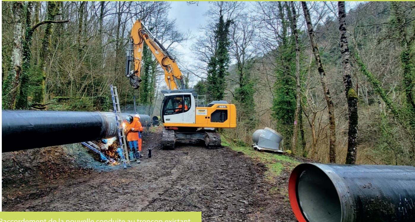
Raccordement de la nouvelle conduite au tronçon existant.
